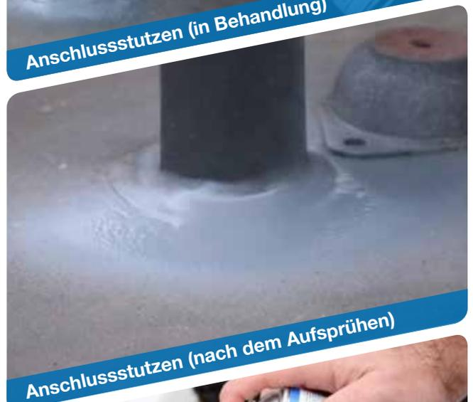
Anschlussstutzen (nach dem Aufsprühen)
